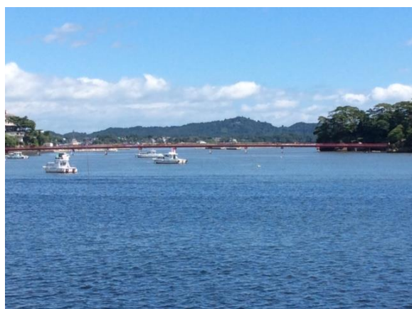
福浦島に渡る橋長 252m の福浦橋
