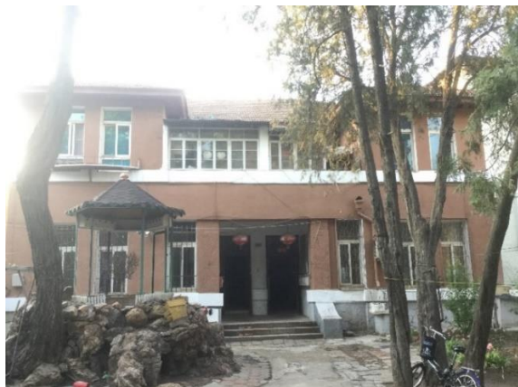
保存されている南満鉄時代の建物
