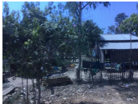
トタン屋根の見すばらしい民家
