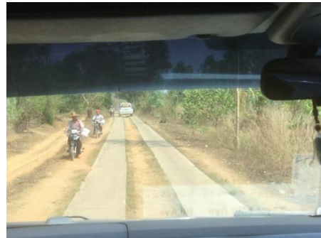
自動車の車輪が通る所だけ舗装された道路
