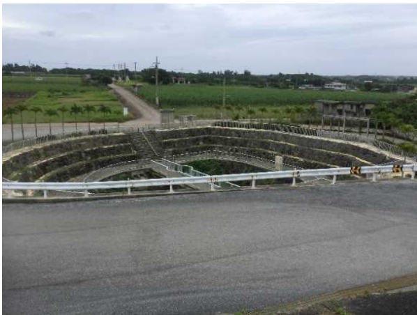
地下ダム資料館の側にある水位観測所。
