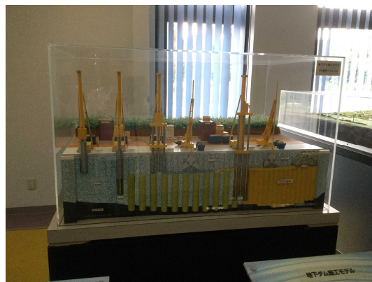
地下連続地下壁の施工の説明模型
