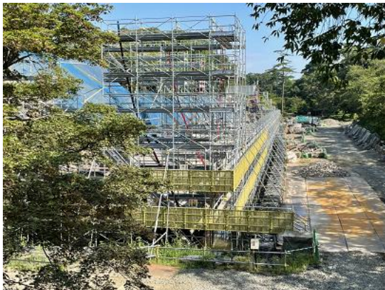
内堀の石垣の修復工事
