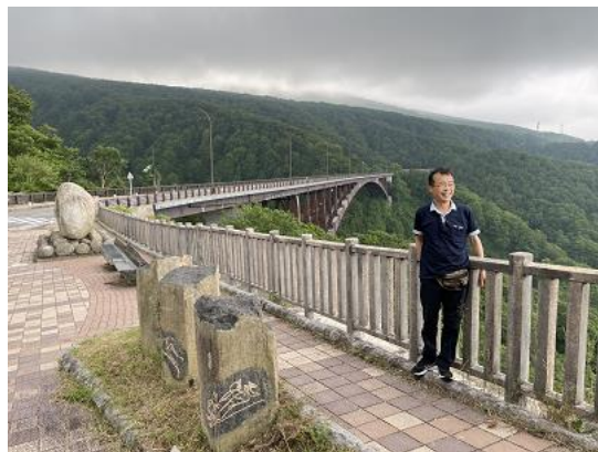
八甲田連峰が一望できる城ヶ倉大橋
