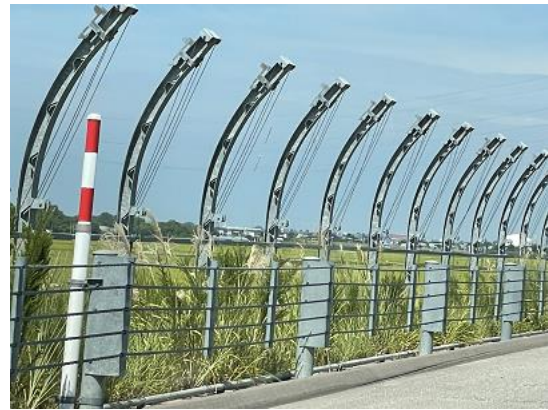
道路の片側には防雪柵が設置されていた
