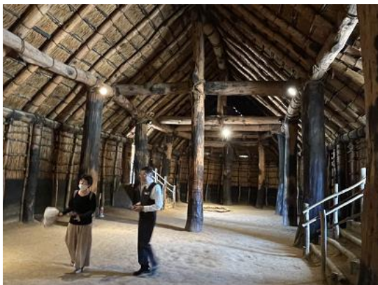
集会場あるいは作業場として作られたと思われる大型竪穴建物。地面を 1.5m ほど掘り下げて床が作られている。
