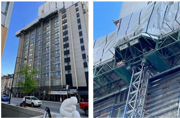
写真 11 モントリオールで宿泊したホテルの外壁補修工事
