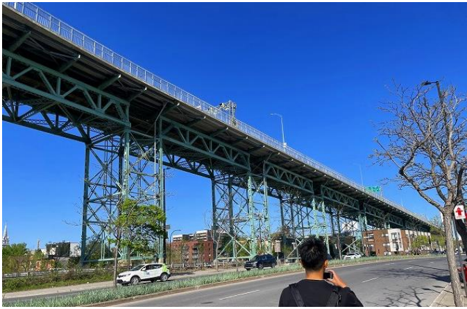
写真6 ジャックカルティエ橋右岸の高架橋
