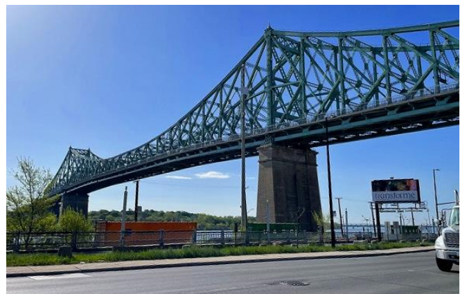
写真5 ジャックカルティエ橋
