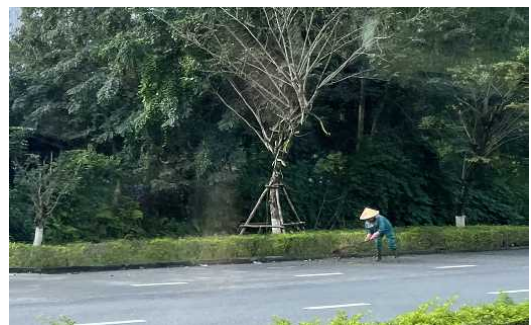
根元が白い樹木と植樹帯を剪定する作業員
