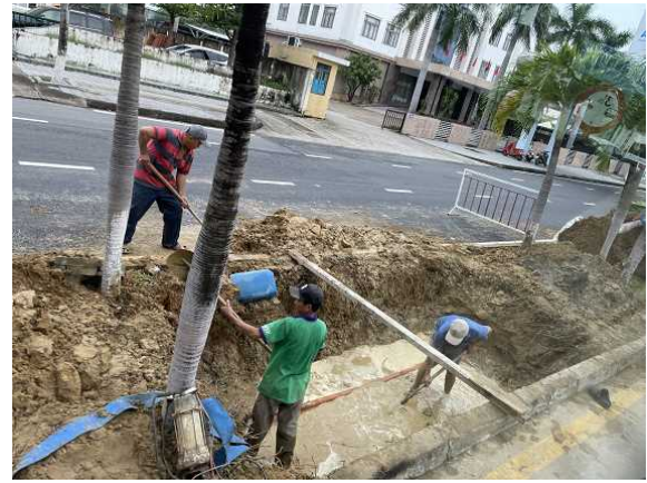
重機を使わず人力作業をしているベトナムの作業員
