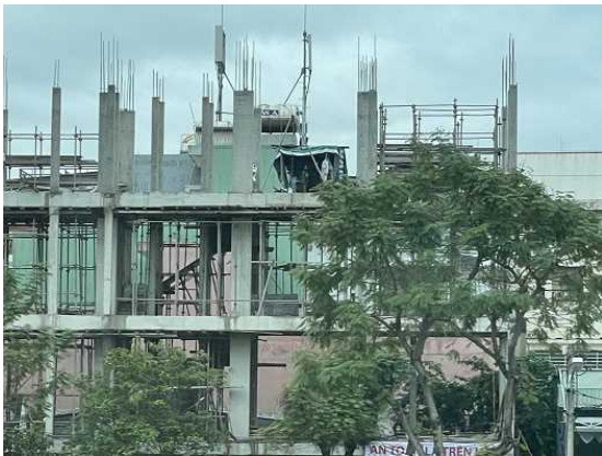
工事中の建物。柱が小さい。
