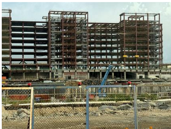
第3ターミナル建設中の桃園国際空港
