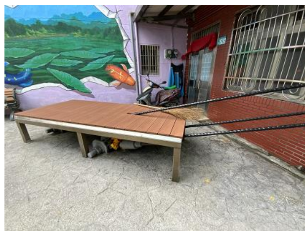
アンカーレッジの上を縁台として有効活用されている
