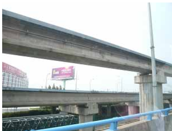
上海トランスラピッドの軌道
