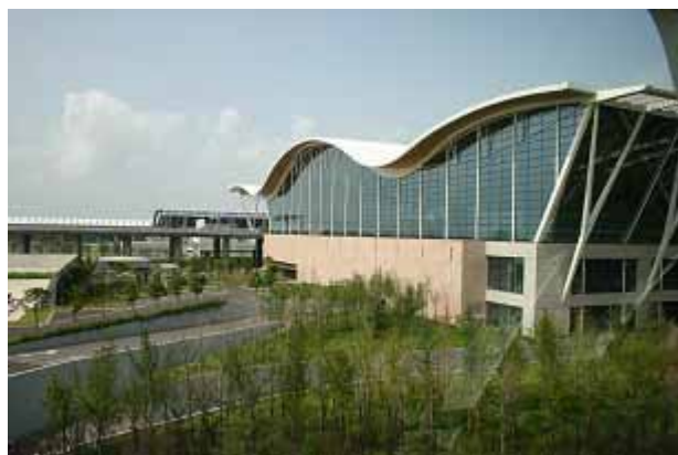
上海浦東国際空港ターミナル
