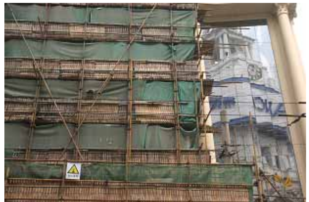
補修工事中のビル。足場は鋼製のパイプであるが、柵には竹が使われている。
