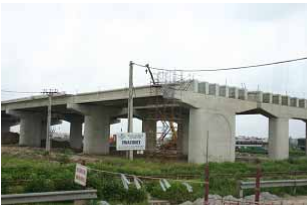
日本のODAによるハイウェイの建設
