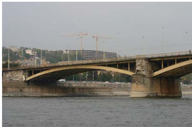
マルギット橋
