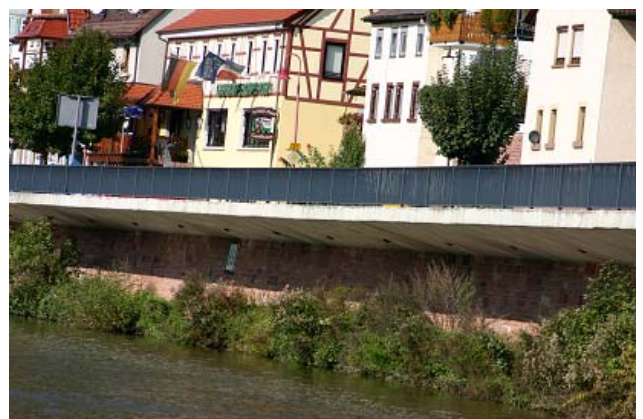
ネッカー川に大きく張り出した構造
