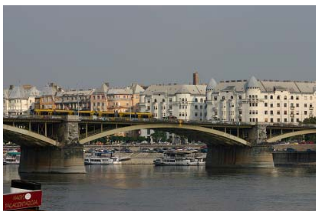
マルギット橋
