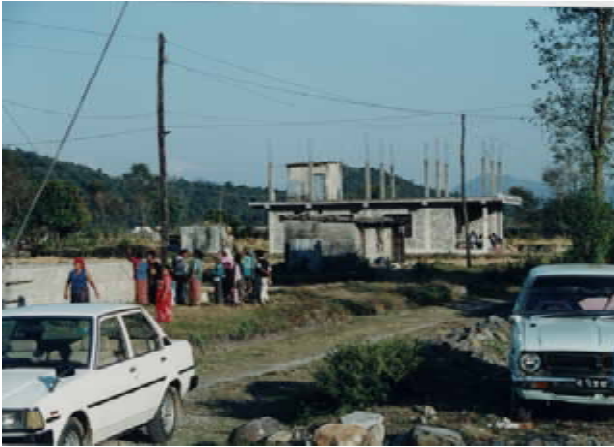
屋根から柱が突き出した民家(ポカラ)
