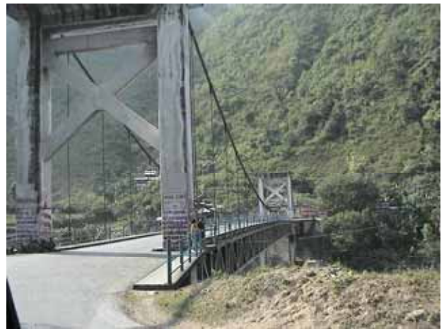
プリティビ・ハイウェイと分岐する道路の吊橋
