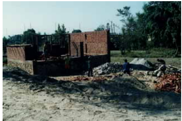
建築中の住宅(チトワン)
