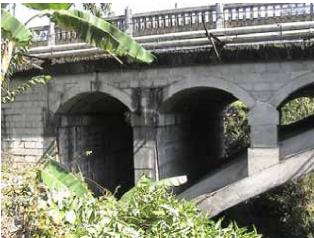
水路橋の隣に架けられたアーチ構造の道路橋
