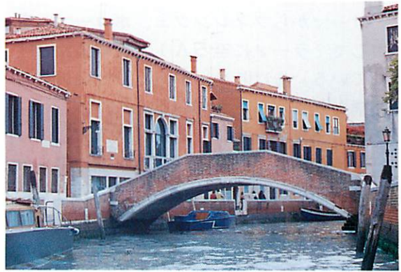
小運河に架かる橋
