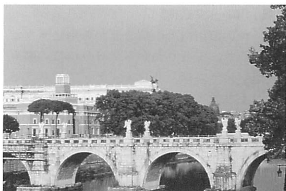
サントアンジェロ橋の側面（ローマ）
