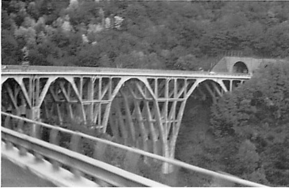
逆ランガー橋
