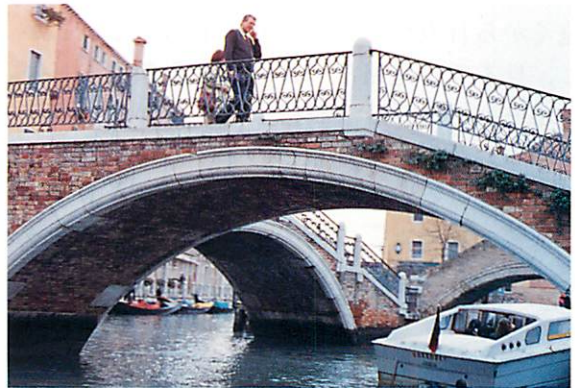
小運河に架かる橋
