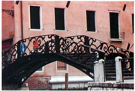
小運河に架かる橋
