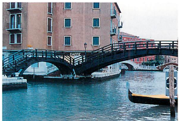
小運河に架かる橋
