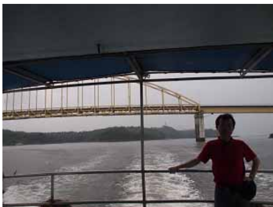
大矢野橋は、橋長 249m のランガートラス橋。
