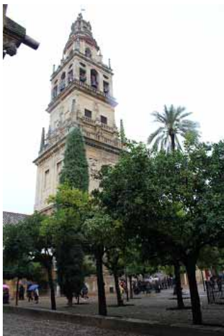
メスキータ・カテドラルの鐘楼
