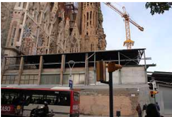
聖家族教会は現在も工事が進められている。
