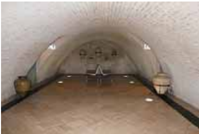
カテドラルのトイレ。景観に配慮して中庭の奥の地下に目立たないように造られている。
