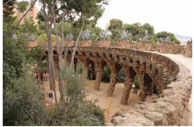
ヤシの木をイメージした橋脚で支えられた橋
