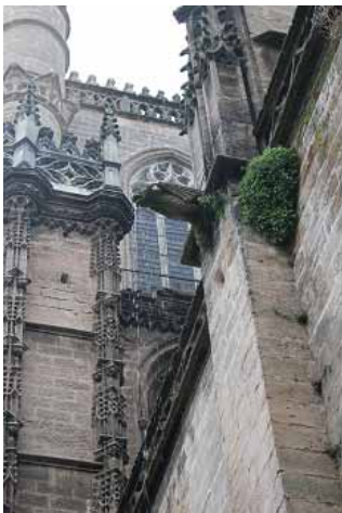
建物の壁面から飛び出しているのは雨樋。
