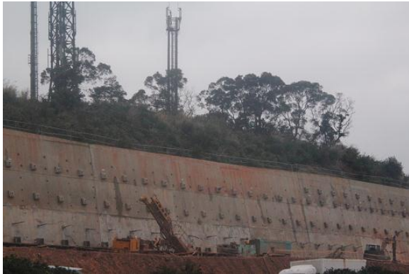
グラウンドアンカーを用いた土留
