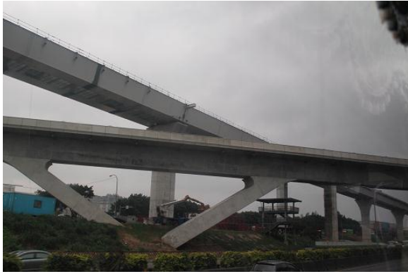
V形橋脚のプレストレスコンクリート橋
