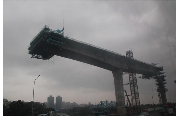
プレキャストセグメント工法による施工
