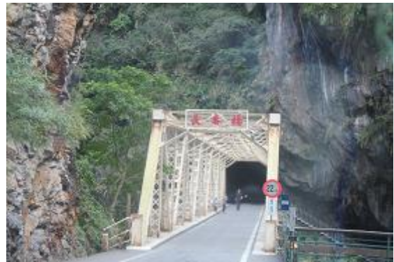
国道から分岐し、長春祠に入る橋梁。
