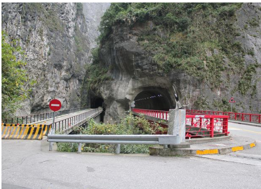
古い下流の橋は上路式のワレントラス橋, 上流の新しい橋はプレートガーダー橋。
