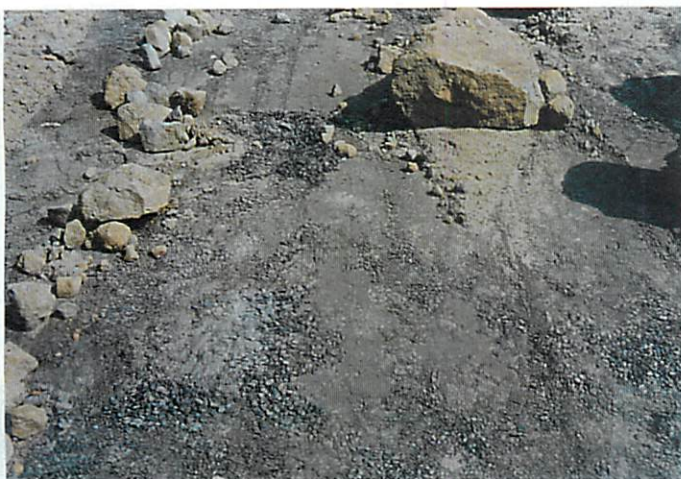
写真 70 叩いたら表面がタイル状に剥離したすべり面
