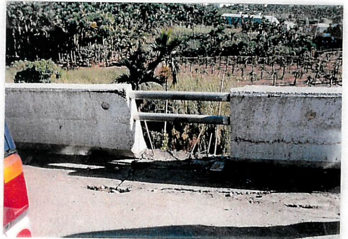
写真 12 片持ばり式擁壁の上部の剛性防護柵
