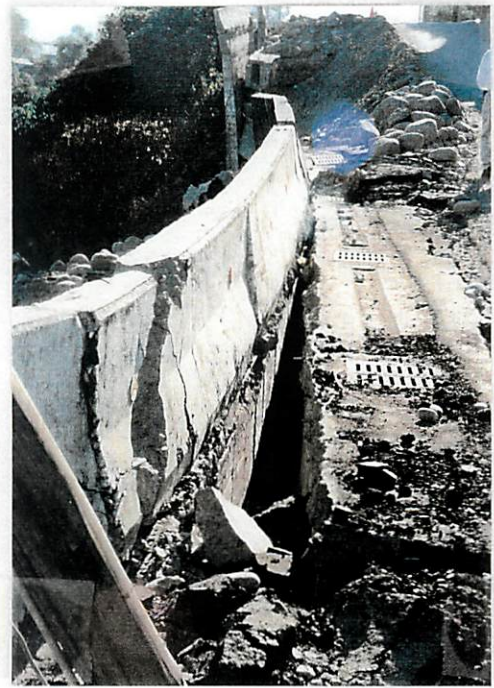
写真 11 前方に迫り出した片持ばり式擁壁
