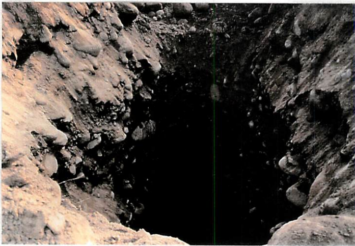
写真 60 堤防の直ぐ横で掘られていた井戸
