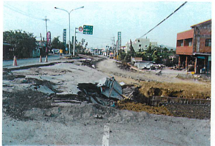
写真 57 隆起した3号線。地震前は，写真右手の家と道路が同じ高さであった。
