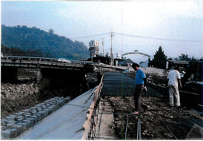
写真 59 成平橋下流の護岸工の補修工事
