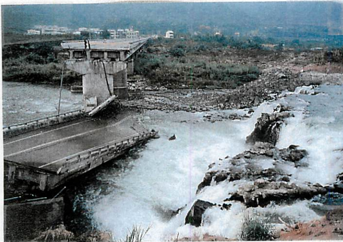
写真2 卑豊橋(豊原)の上流(東側)が 6m 隆起し河川に滝ができた
