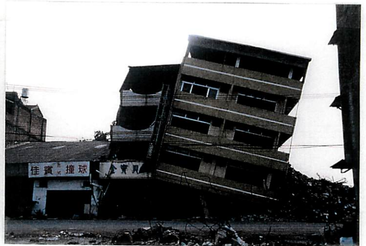
写真 62倒壊した竹山市街地の建物
