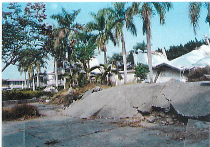
写真 40 光復国中学校の校庭内の断層
