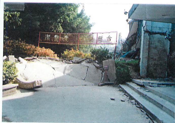
写真 45 北館の北側の校庭の段差
