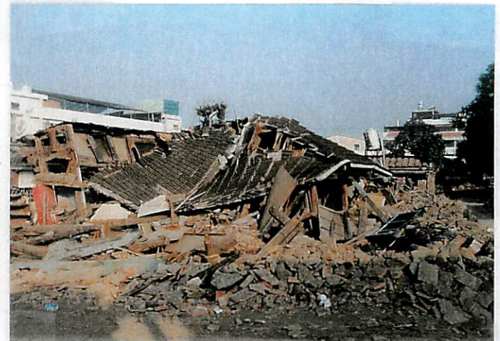
写真 27 東勢の伝統的建築物の倒壊
