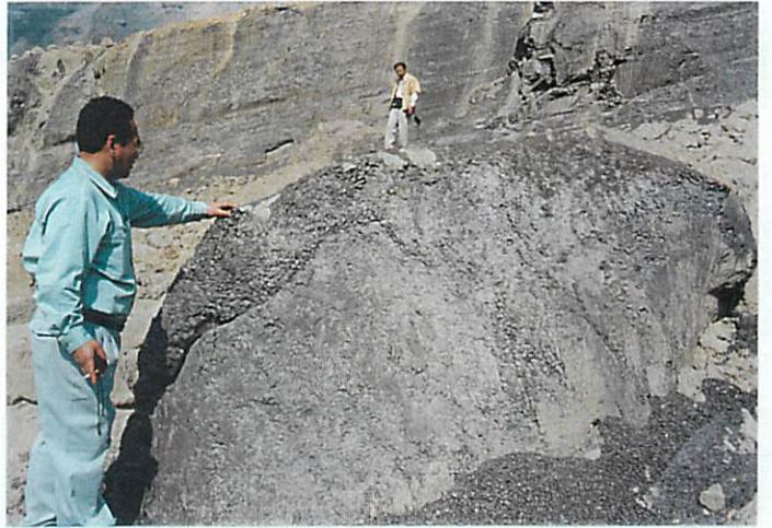
写真 71 すべり面上の頁岩の転石。叩くと表面がタイル状に剥離する。
