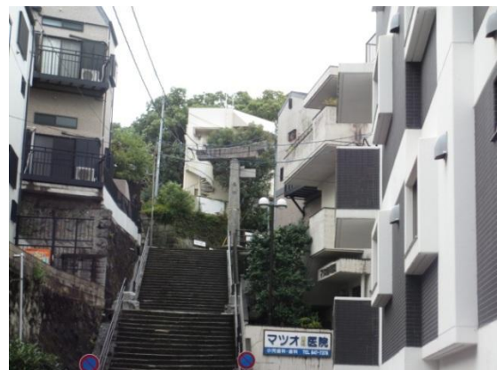
山王神社の二の鳥居。原子爆弾の炸裂による爆風によって片方の柱がもぎとられている。
