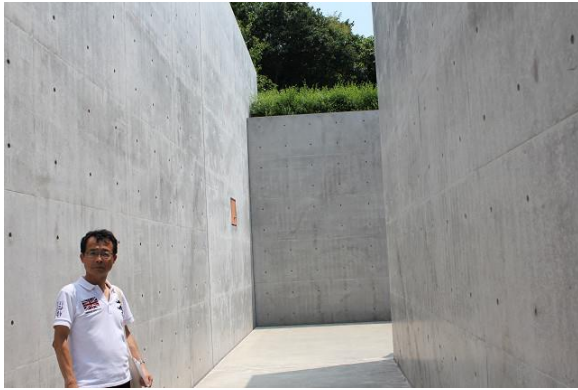
美術館の入り口。いかにも安藤忠雄の作品らしいコンクリート打ちっ放しの壁。
