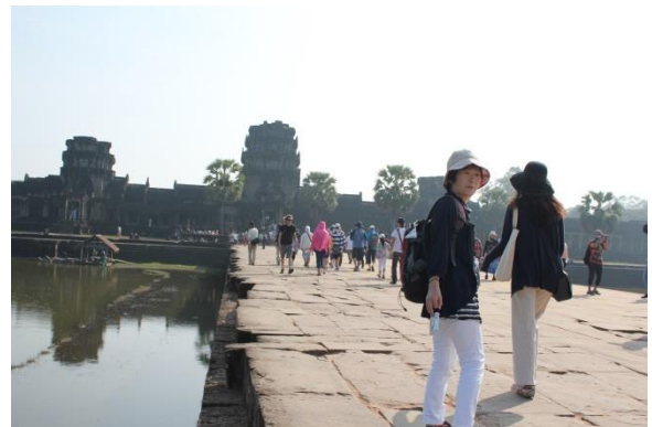
奥に見える建物は正門の西大門。西大門に入るため、高さ 4m、幅 12m の盛土構造の参道がある。参道には蛇神ナーガの欄干が設置されていたが、堀に落ちて残っていない。
