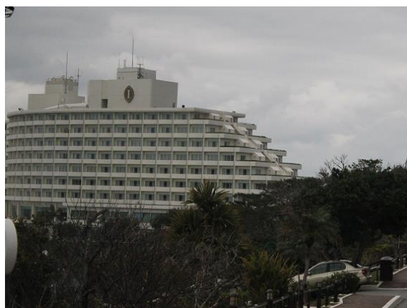
ANA インターコンチネンタル万座ビーチリゾートは、万座毛の対岸に建つ白亜の総合リゾートホテル。昨年が開業 30 周年であった。
